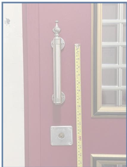
1 注意電子鎖安裝範圍 393.6x79mm內是否有不可拆卸的阻礙物，以及安裝後是否能遮住原有開孔
