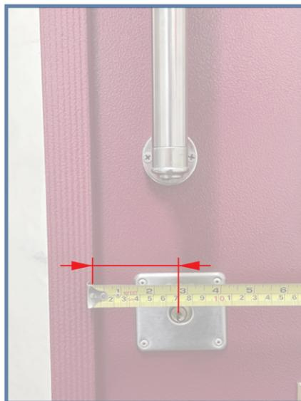
2 量測原有門鎖鎖孔到門邊緣的長度(裝置距離)
