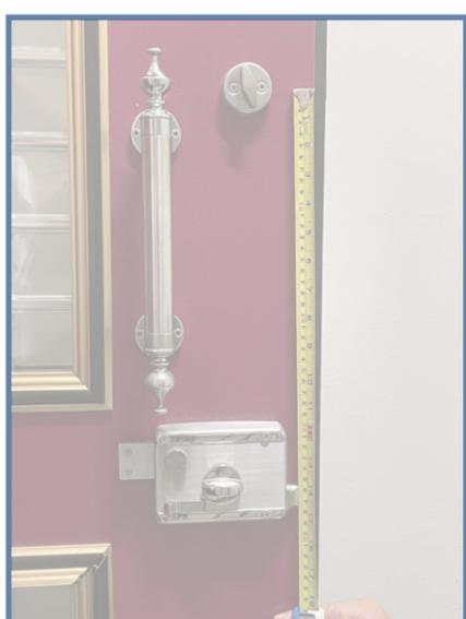
7 注意電子鎖安裝範圍 393.6x79mm內是否有不可拆卸的阻礙物，以及安裝後是否能遮住原有開孔
