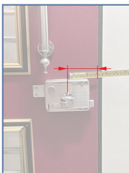
8 量測原有門鎖鎖孔到門邊緣的長度(裝置距離)
